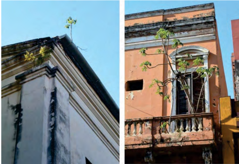
Fig. 1. A y B. “Ambay”, C. pachystachya . A. Desarrollo de la planta en la canaleta ubicada en la parte alta del techo del edificio de la ex-Facultad de Medicina, UNA. B. La planta alcanzando un importante desarrollo en el balcón de una vivienda abandonada.
